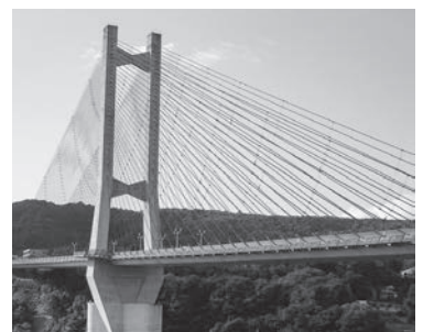
ライトアップ予定の秩父公園橋
