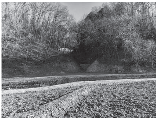
崩流土砂が撤去された様子
