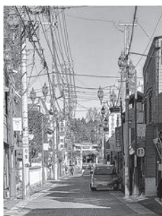
電線地中化される番場通り
