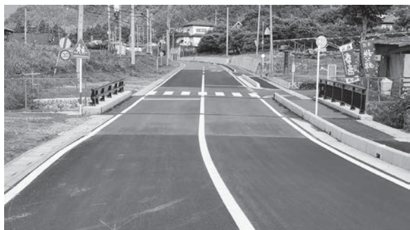
改良が進む荒川幹線4号線(宮沢橋)
