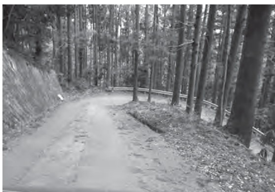
道路整備が必要な大棚地区道路
