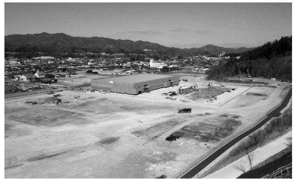
企業誘致が進む旧秩父セメント第一プラント跡地
