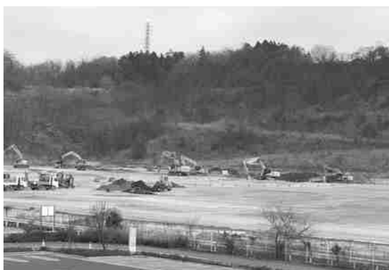
整備が進むセメント工場跡地
