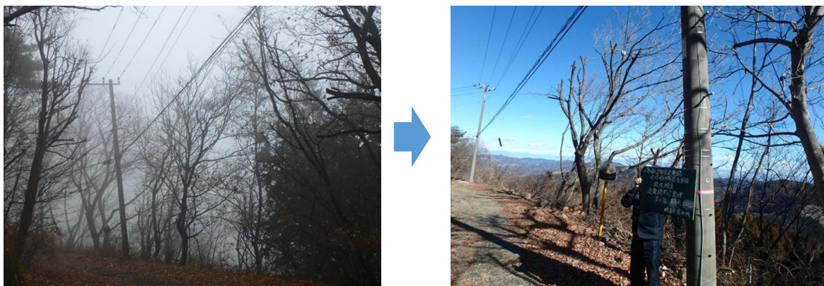
送電線下伐採 実施前（左）と実施後（右）
