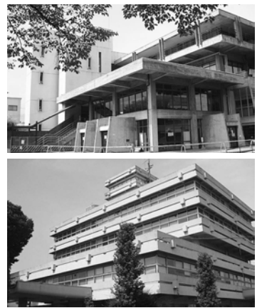
被災し使用できなくなった旧市民会館（上）、旧本庁舎（下）
