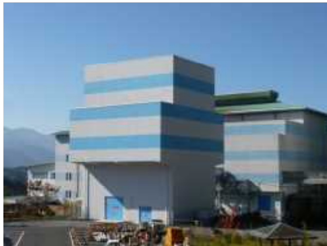
図 6-2-2 秩父クリーンセンターにおける蒸気タービン発電設備
