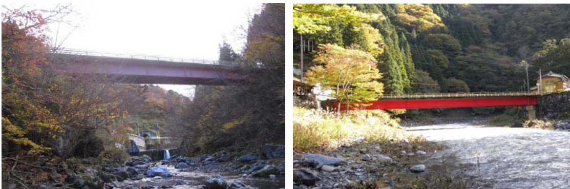
写真 3 孤立集落につながる橋(左:金倉橋、右:中双里橋)
