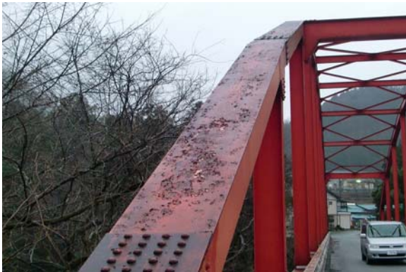
平和橋（1972 年架設 橋長 81.7m）
