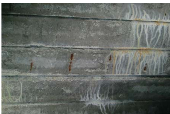
47号橋（1960年架設 橋長 14.6m）
