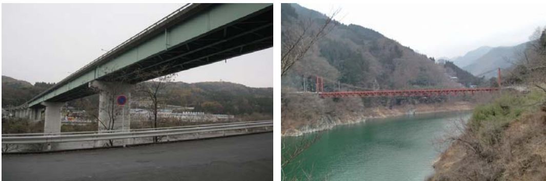
写真 2 長大橋(左:佐久良橋、右:太田部橋)
