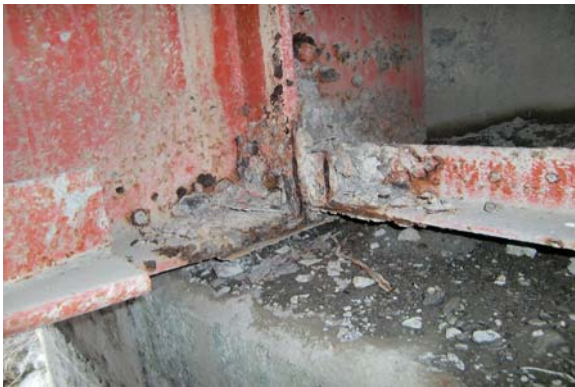
上石橋（1959 年架設 橋長 25.2m）
